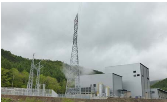
(株)ウツティかわい 区界発電所
