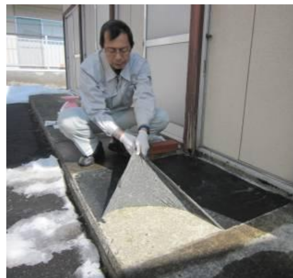
写真3 剥離作業 (コンクリート)
