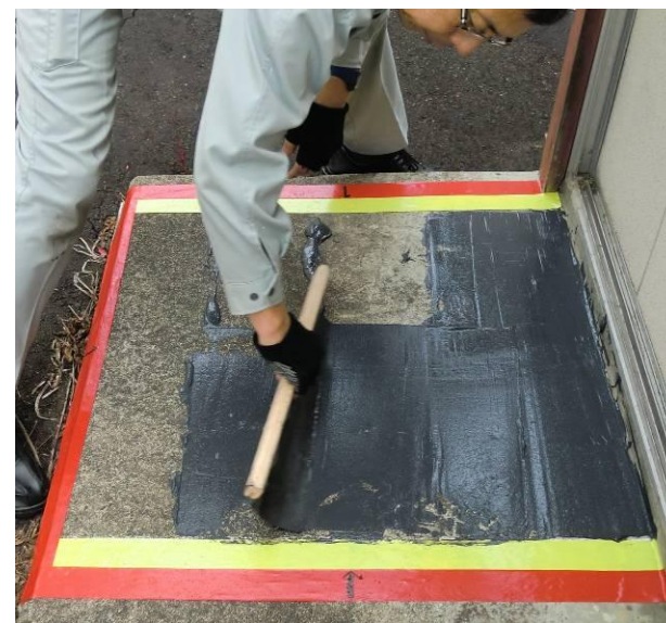
写真2 塗布施工 (漆喰用へらによる塗布)
