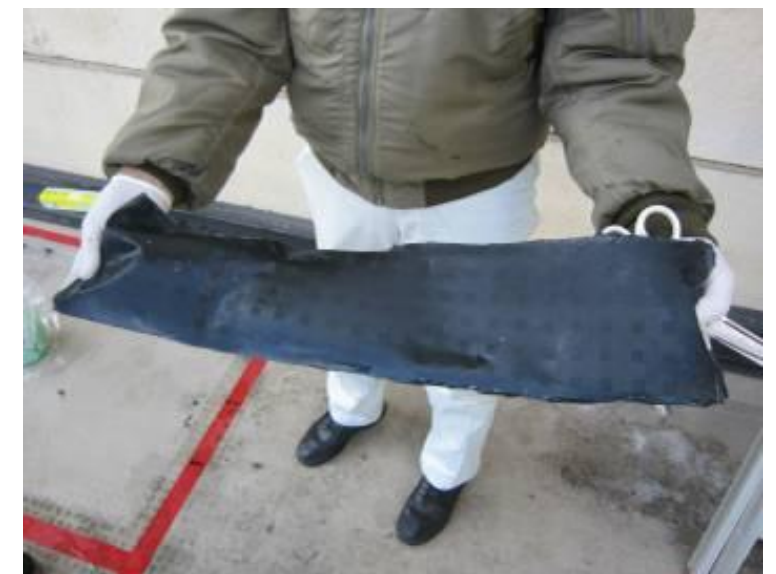
写真4 剥離後のシート事例
