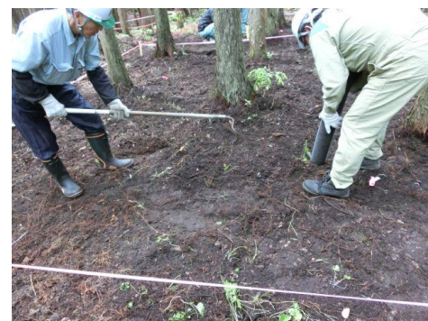
写真2 熊手による前処理からバキューム装置によるA0層除去
