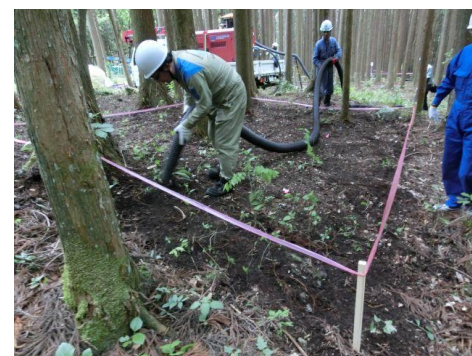
写真3 バキューム装置によるA0層除去
