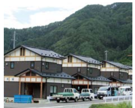
建設中の災害公営住宅(大槌町 平成26年9月)
