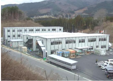
陸前高田市仮設庁舎
