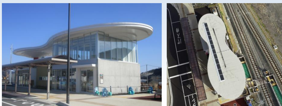
(大槌町：観光交流施設太陽光発電設備)
