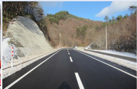
一般国道281号 大坊の2工区 (R2.12.22開通 岩手町)
