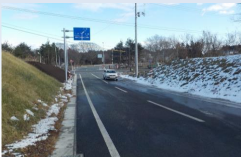
一般県道 明戸八木線 小田の沢工区 (R2. 12. 22 開通 洋野町)
