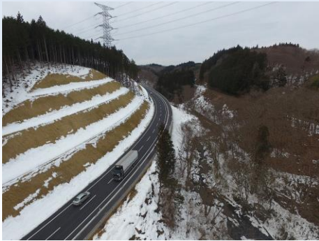
一般国道 284 号 石法華工区 (R3. 1. 24 開通 一関市)
