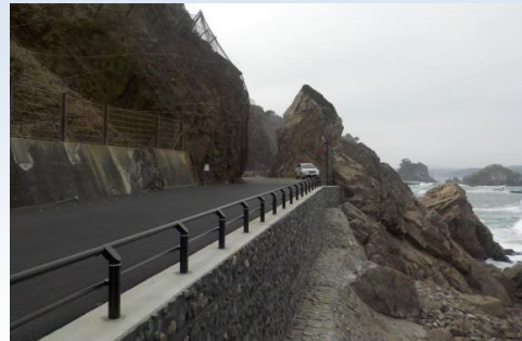
一般県道 野田長内線 小袖～大尻工区 (R3. 3. 31 開通 久慈市)
