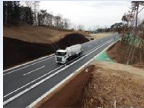
一般国道342号 白崖工区 (R4.3.30開通 一関市)
