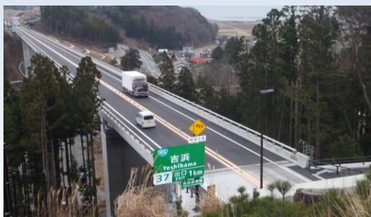
三陸沿岸道路（吉浜道路） (H27. 11. 29 開通)
