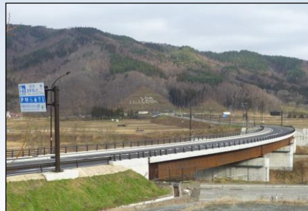
一般県道遠野住田線新里工区開通 (H27. 12. 5 遠野市)
