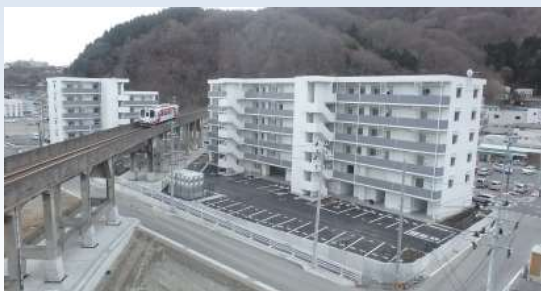
釜石市松原地区 (H29. 3 月完成)
