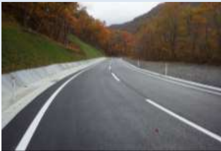
主要地方道久慈岩泉線大月峠工区開通 (H28. 11. 22 岩泉町)
