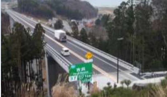
三陸沿岸道路（吉浜道路） (H27. 11. 29 開通)
