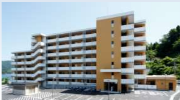
大船渡市上平地区 (H27.6.25完成)
