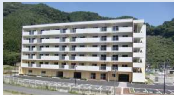
釜石市日向地区 (H27.7.24完成)
