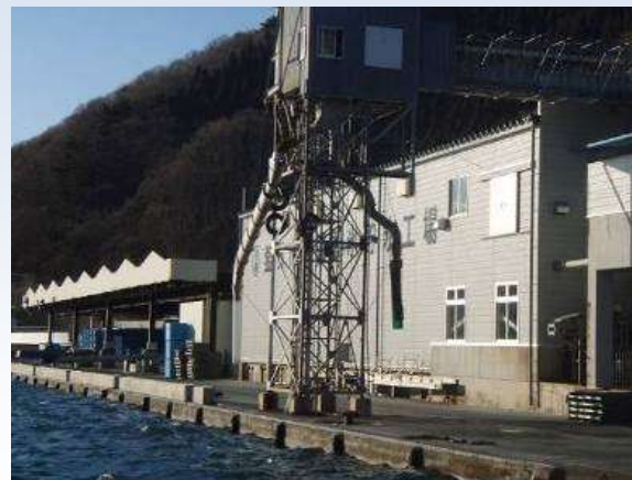
製氷・荷捌き施設(釜石市)
