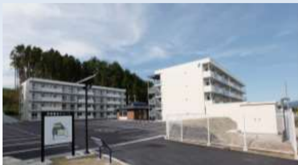
山田町妻の神地区 (H27. 10. 21 完成)
