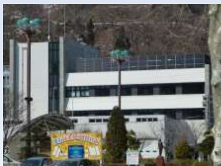
(釜石市：消防署庁舎の太陽光発電)
