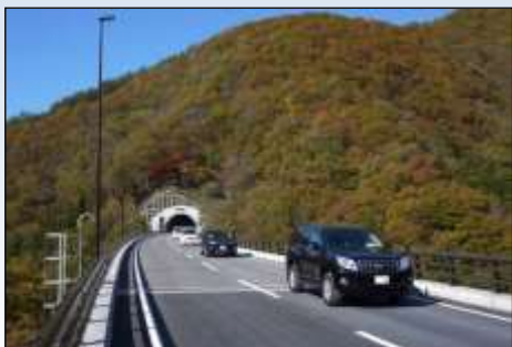
一般国道 397 号「津付道路」供用 (H26. 10. 26 住田町)
