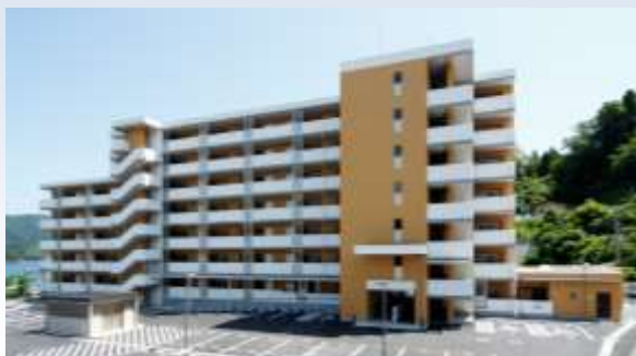
大船渡市上平地区 (H27.6.25完成)
