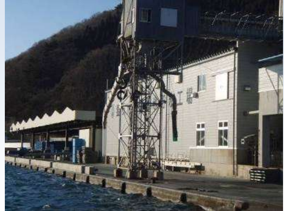
製氷・荷捌き施設(釜石市)
