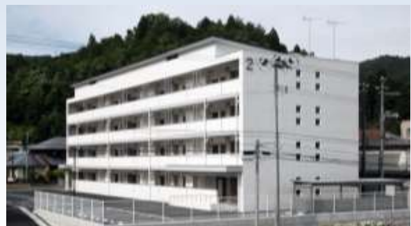
宮古市西町地区 (H27.6.5完成)
