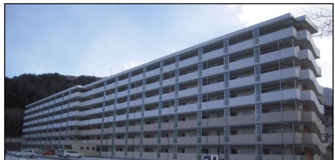
釜石市平田地区（H26. 1. 24 完成）
