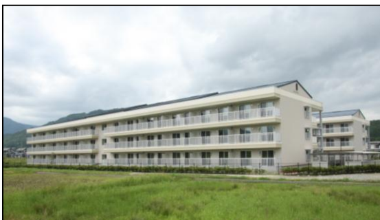
山田町豊間根地区（H26. 6. 27 完成）
