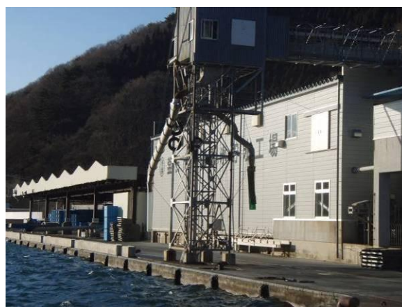
共同利用施設の復旧支援により整備 した製氷・荷捌き施設 ( 釜石市 )
