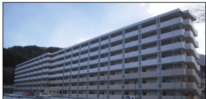
釜石市平田地区（H26. 1. 24 完成）
