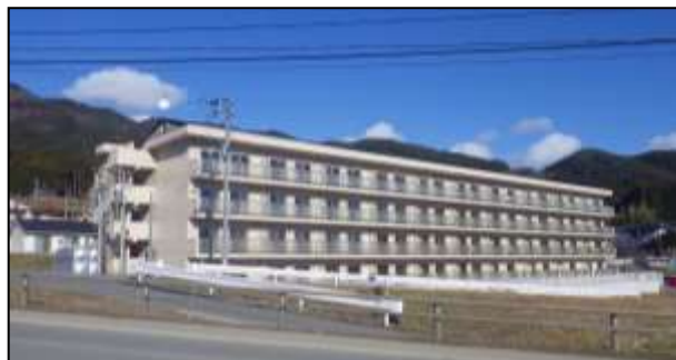
陸前高田市西下地区（H26.12.19完成）
