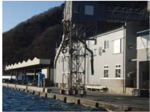
共同利用施設の復旧支援により整備 した製氷・荷捌き施設 ( 釜石市 )
