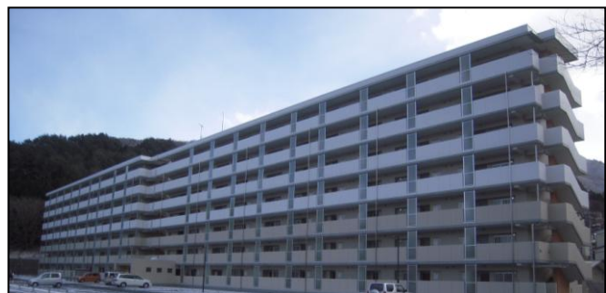
釜石市平田地区 (H26. 1. 24 完成)
