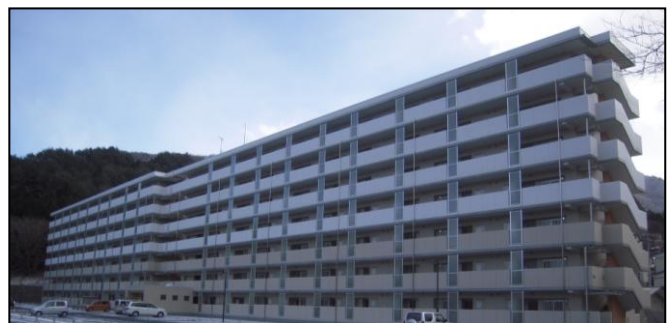
釜石市平田地区 (H26. 1. 24 完成)
