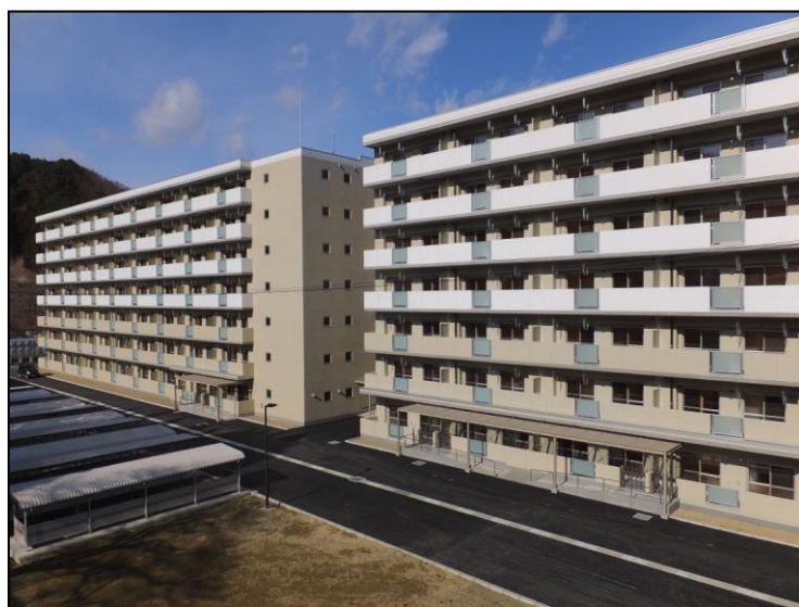
完成した災害復興公営住宅の様子
