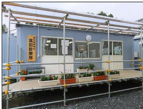
陸前高田市に設置された仮設の診療所
