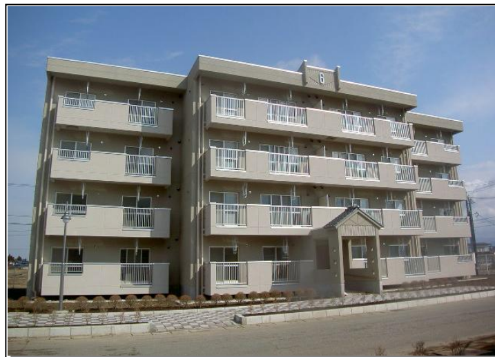
災害復興公営住宅の完成イメージ
