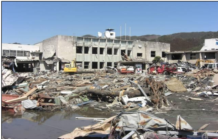
被災した大槌町役場
