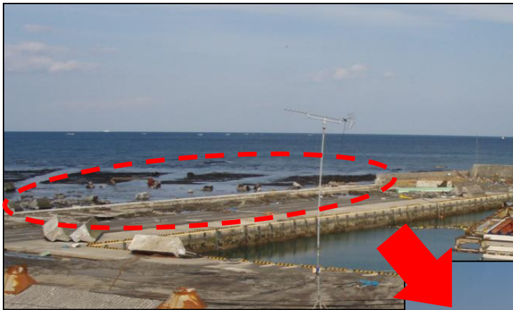
津波により消失した護岸上の胸壁 (点線赤枠内の部分)
