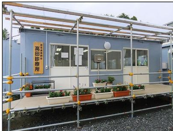
陸前高田市に設置された仮設の診療所
