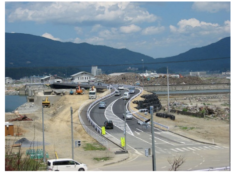
陸前高田市での仮橋復旧
