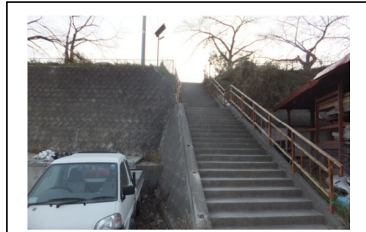
赤崎地区漁村センターに通じる階段（赤崎小学校側）
