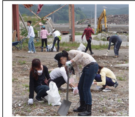
がれき・ごみの処理を手伝うボランティア (陸前高田市内・平成23年8月5日)
