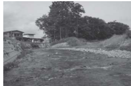
多自然川づくり (矢神川、八幡平市)
