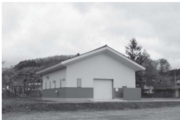
浄法寺浄化センター（二戸市）
