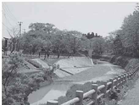
護岸の緩傾斜化により親水空間を創出した後川（花巻市）
