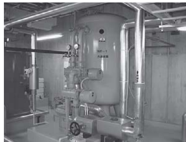
雨水貯留施設（二戸地区合同庁舎）
