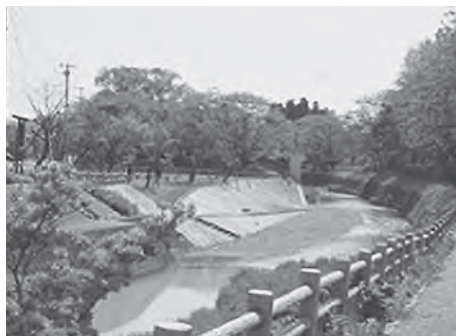
護岸の緩傾斜化により親水空間を創出した後川 (花巻市)
