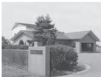
西根浄化センター
