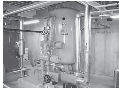
雨水貯留施設（二戸地区合同庁舎）
