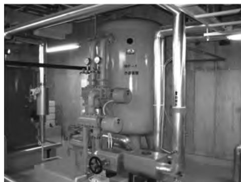
雨水貯留施設（二戸地区合同庁舎）
