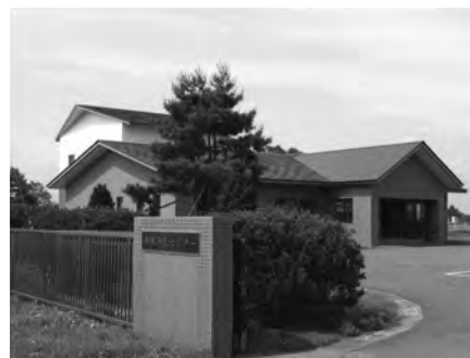
西根浄化センター
