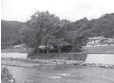
河畔林を保全するため護岸工法に配慮した雫石川（雫石町）
