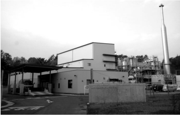
いわて第2クリーンセンター全景
