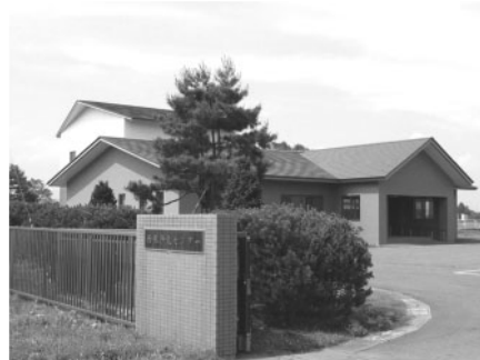
西根浄化センター
