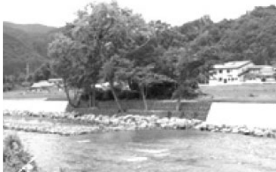
河畔林を保全するため護岸工法に配慮した雫石川 (雫石町)
