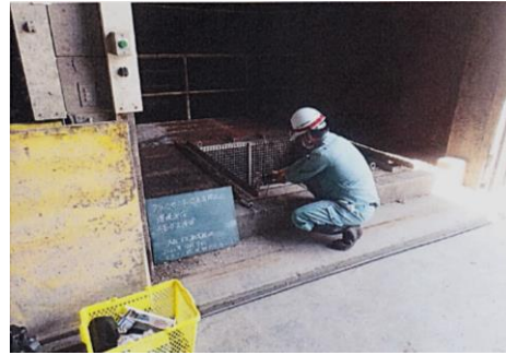
有害ガス測定
