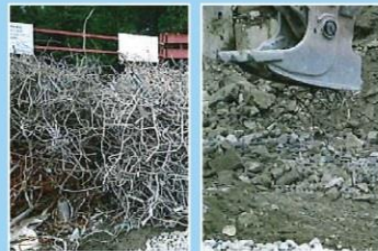
工事現場などで出たアスファルトがら。
