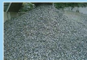
細かく破砕して再生砕石・再生砂にします。
