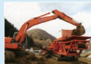
土木工事などで再利用されています。石灰を混ぜ込み、道路を固く頑丈にしています。
