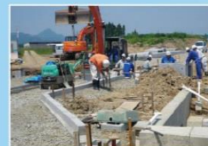
道路工事などで再利用されています。
