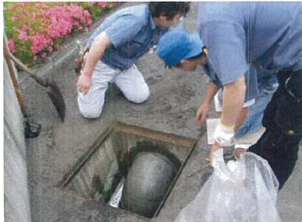
工場最終排水溝（分離層）の清掃
