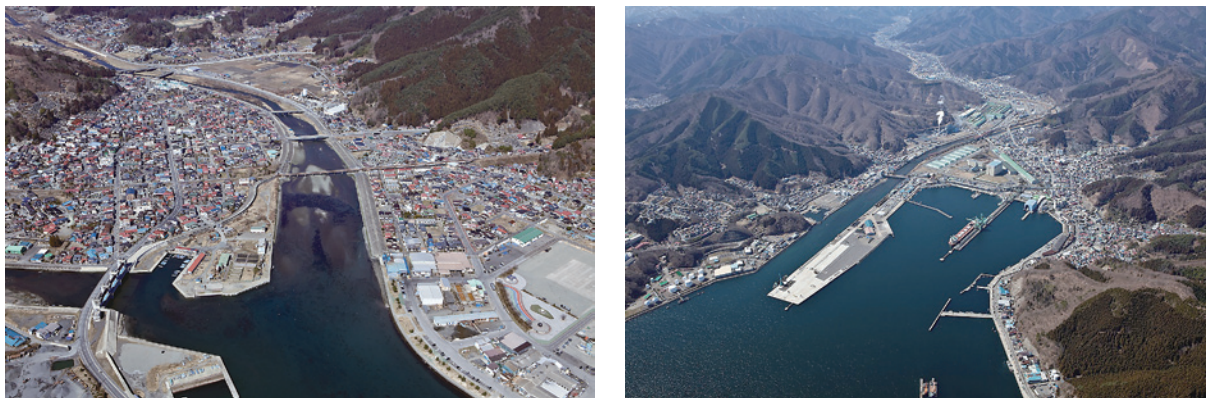
被災前の状況（左：大槌町大槌川河口、右：釜石市須賀地区海岸）。山が海際まで迫り少ない平坦地に住宅や産業施設が密集する。
