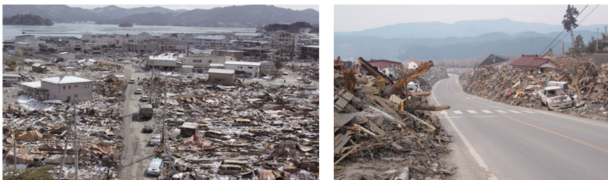
写真 2.3.1 道路啓開後の状況（左：山田町提供、右：陸前高田市提供）
