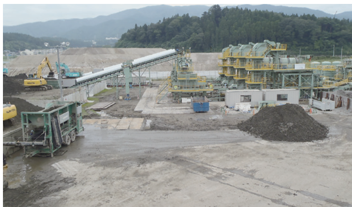
写真 3.5.13 土壌分級処理施設（陸前高田市提供）
