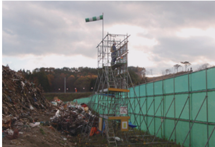
写真 3.5.5 監視台及び吹流し（列車見張員の配置、風向と風速の測定）
