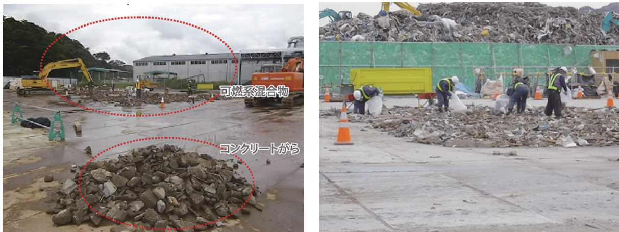
写真 3.5.1 一次仮置場における粗選別の状況 (宮古地区)
