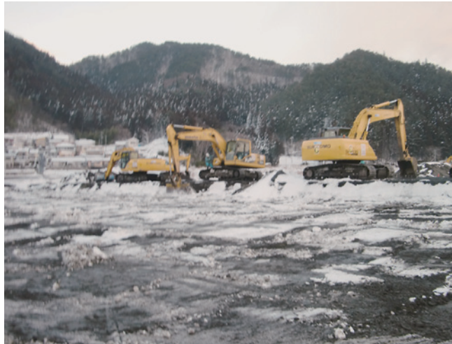
写真 3.17.3 二次仮置場での除雪作業（大槌地区）
