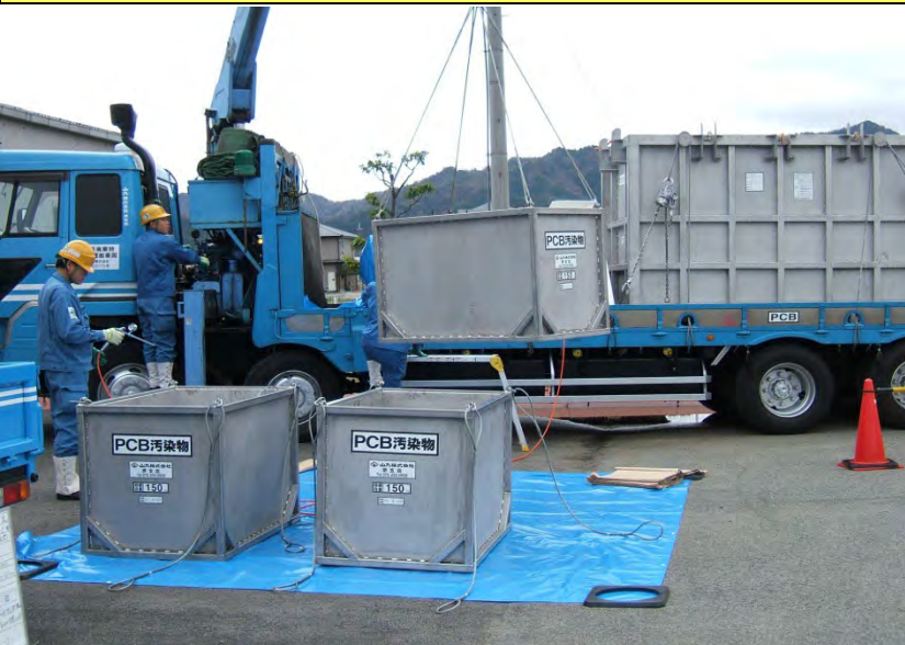
③ トレイ内の漏れ対策に吸収材を入れる
