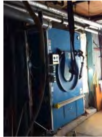
業務用乾燥機と分電盤に 設置されていた低圧コンデンサー ※上記写真のコンデンサーはPCB含有無し
