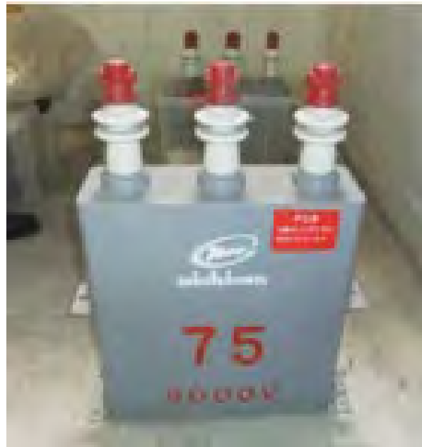
電力用コンデンサー
