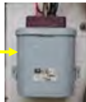
分電盤に設置された低圧コンデンサー
