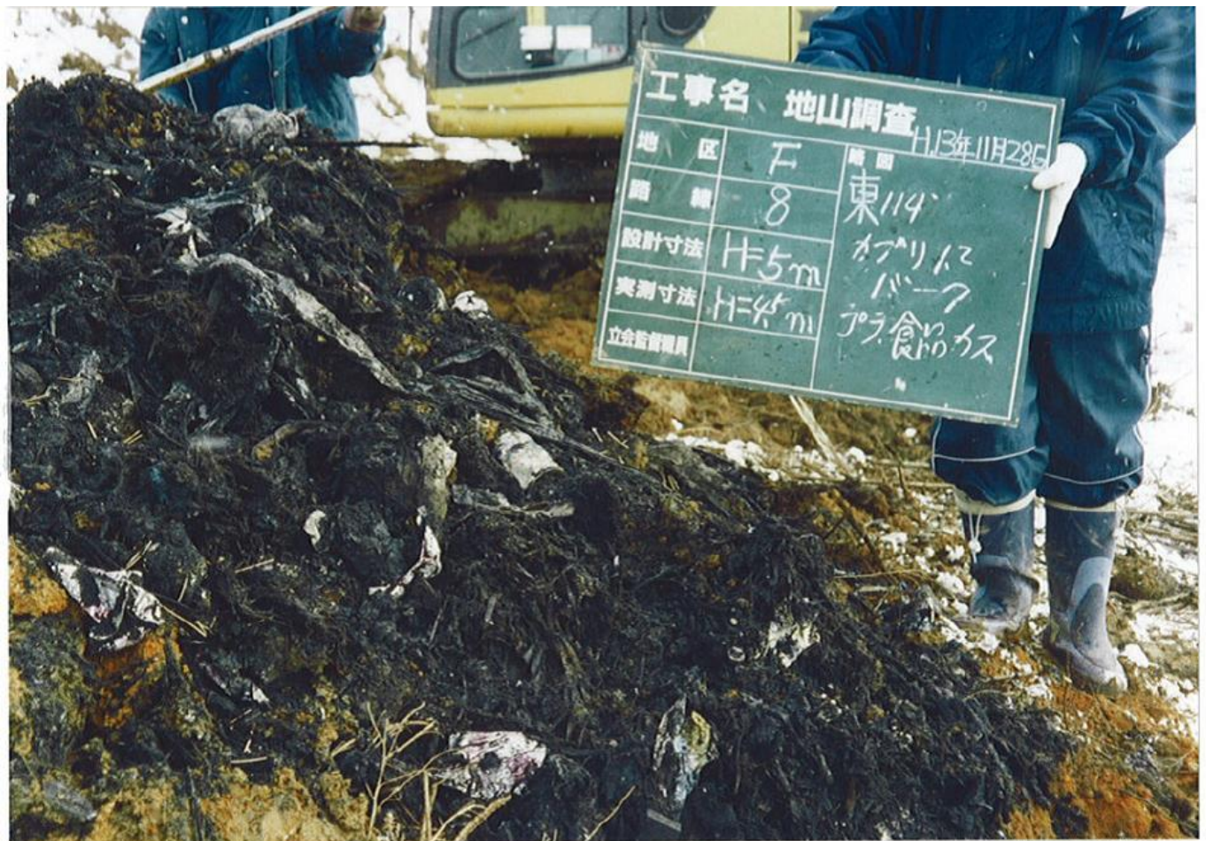
場内のトレンチ(筋掘り)調査状況
