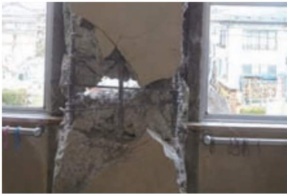
一関市立山目小学校の校舎内部(平成23年3月23日) 一関市教育委員会提供
