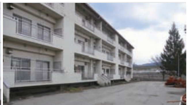
復旧後(平成24年12月25日) 同校提供
