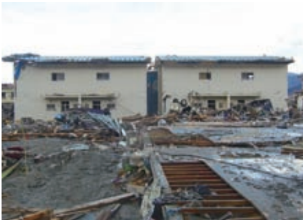
県立高田高等学校教職員住宅(平成23年3月16日)
