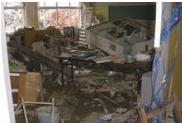
大船渡市立赤崎小学校の教室(平成23年5月30日)
