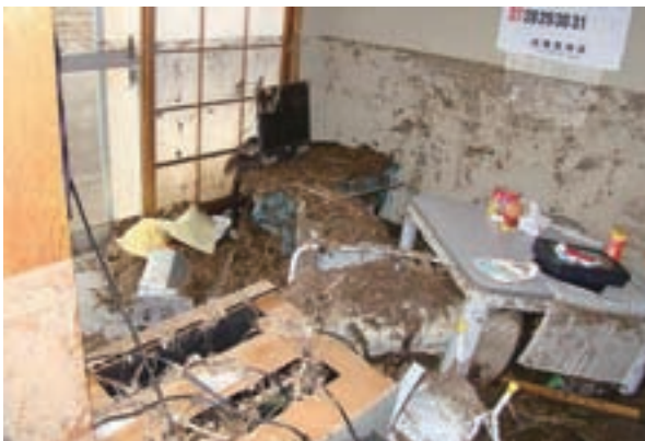
県立宮古北高等学校教職員住宅(平成23年3月15日) 同校提供
