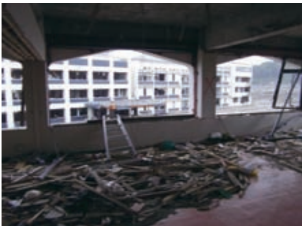
被災した陸前高田市教育委員会事務局。正面は市庁舎（平成23年6月2日） 陸前高田市教育委員会提供
