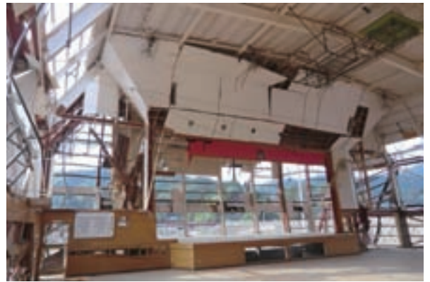
釜石市立唐丹小学校の体育館(平成23年5月25日)
