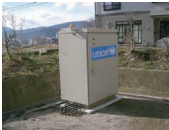
ユニセフの支援で陸前高田市立高田小学校に設置された浄化槽 陸前高田市教育委員会提供
