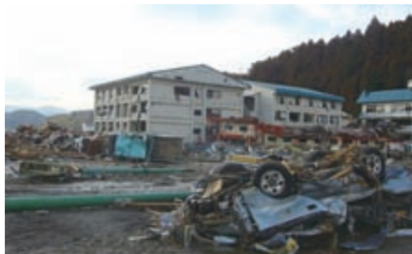
被災した県立高田高等学校の校舎(平成23年3月16日)
