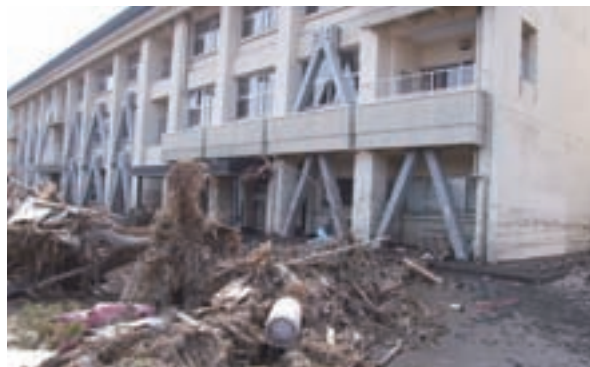
県立宮古工業高等学校のがれきが押し寄せた校舎1階(平成23年3月13日)同校提供
