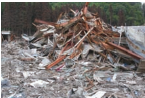
釜石市立鶯住居小学校の体育館(平成23年5月25日)
