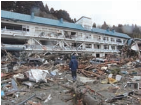
津波により屋上近くまで水没した県立高田高等学校校舎 同校提供
