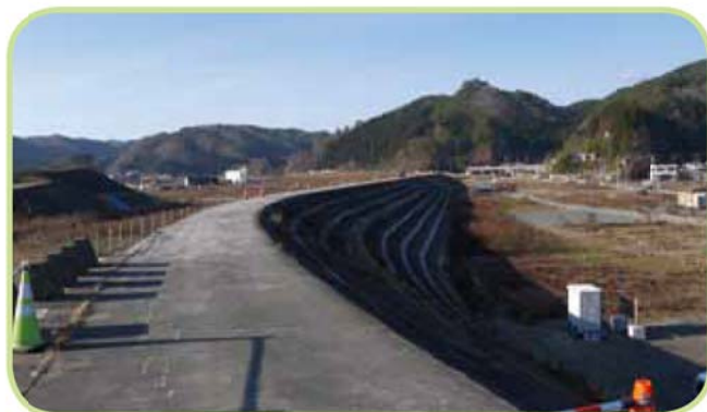
防潮堤の内も外も、家は津波にこわされた
