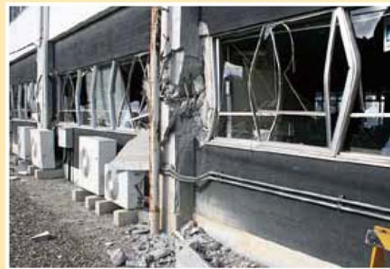
震度5強の地震が鉄きんコンクリートの市役所をこわした(遠野市)
