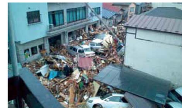
津波が町をはかいました(写真は釜石市)
