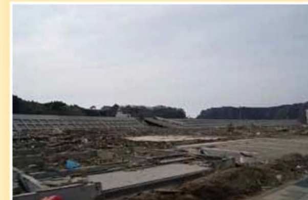
日本一の防潮堤も町を守れなかった(宮古市田老)
