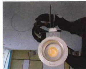
写真－天井下地と天井に付く部材をワイヤーで固定
