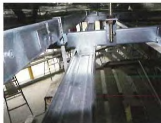
写真－クリップを使用しない天井下地工法
