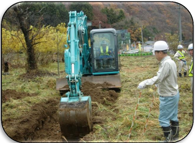
重機による掘削の指示
