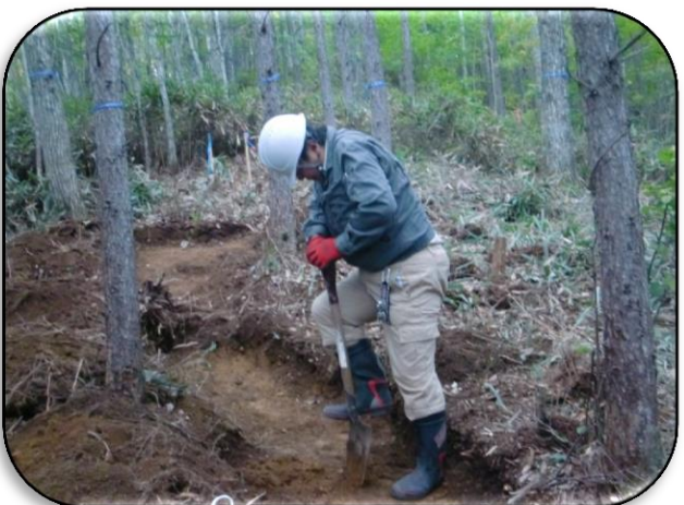
人力での掘削
