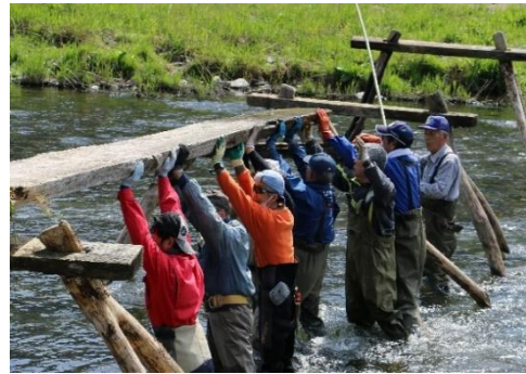
▲住田町 下有住地区（中山間賞受賞集落） 下有住名物「松日橋」の修復
