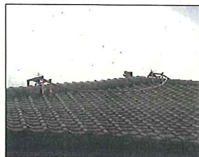
↑牛舎屋根に設置したスプリンクラー
