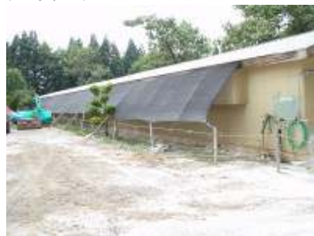
寒冷紗の設置
