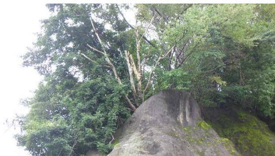
釜石市大平町（施工前）
