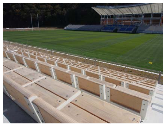
釜石鶴住居復興スタジアムへの被害材の活用
