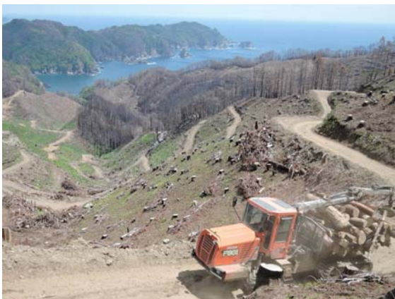
復旧作業の状況（H30.5 現在）
