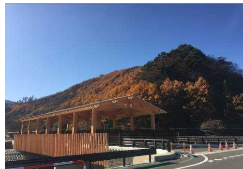
大橋（町道葛巻浦子内線）
