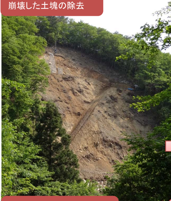
復旧前(1号箇所) 下部の土塊の除去
