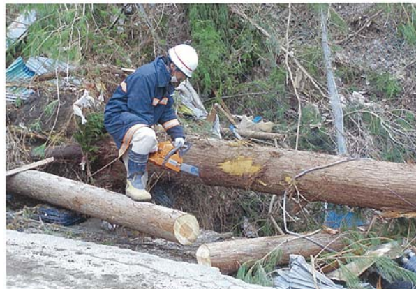
地域住民と地元消防団によるガレキ撤去状況（H23.3.20撮影）
