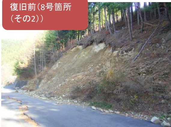
復旧後(8号箇所 (その2))
