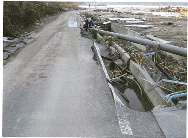
(写真二) 吉里吉里線の被害状況
