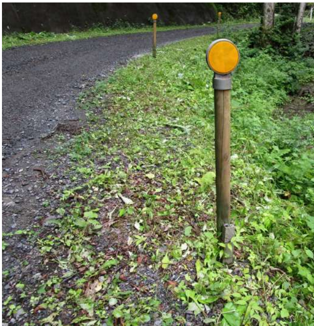
二次製品(さや管式)の施工例
